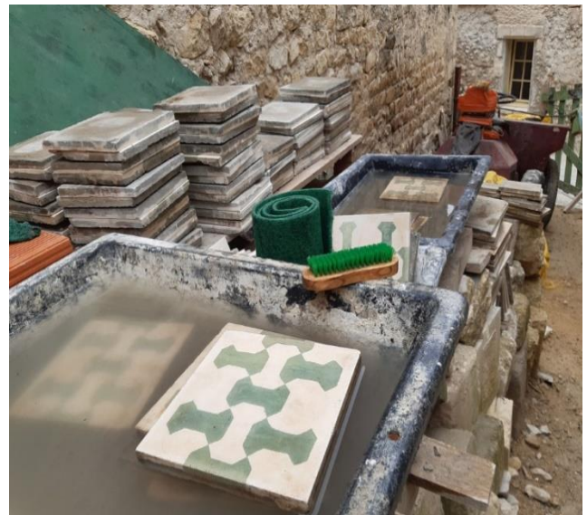
Reinigung der alten Zementfliesen für den Treppenabsatz im 1. Stock
